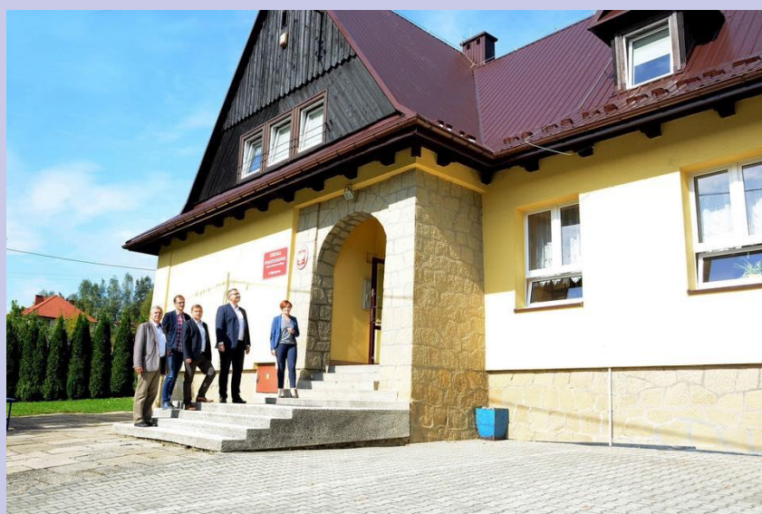
Remont dachu w SP w Bęczarce
