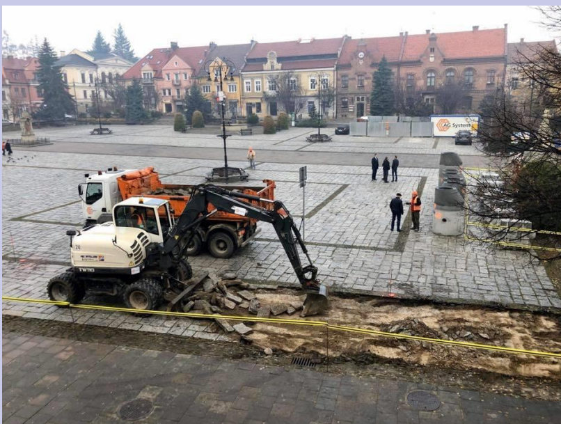
Rozpoczęcie prac rewitalizacyjnych na myślenickim Rynku i przyległych ulicach (2 etap rewitalizacji)
