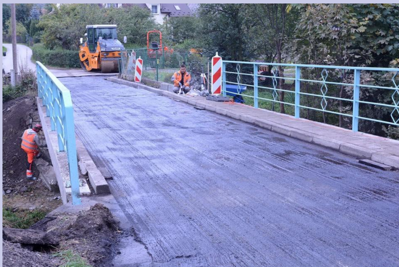
Remont mostu w Trzemeśni
