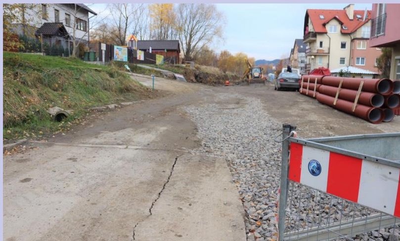
Rozpoczęcie budowy nowego odcinka ul. Solidarności w Myślenicach
