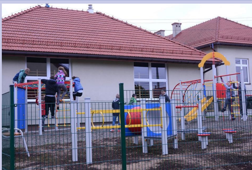
Budowa 4 Otwartych Stref Aktywności w Zawadzie, Zasani, Krzyszkowicach i Porębie
