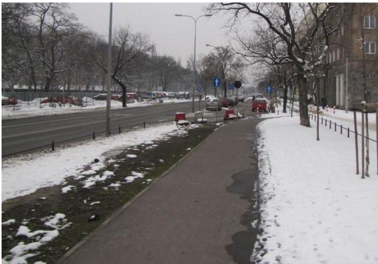
Zdjęcie 16. Podgrzewana ścieżka rowerowa w Warszawie
